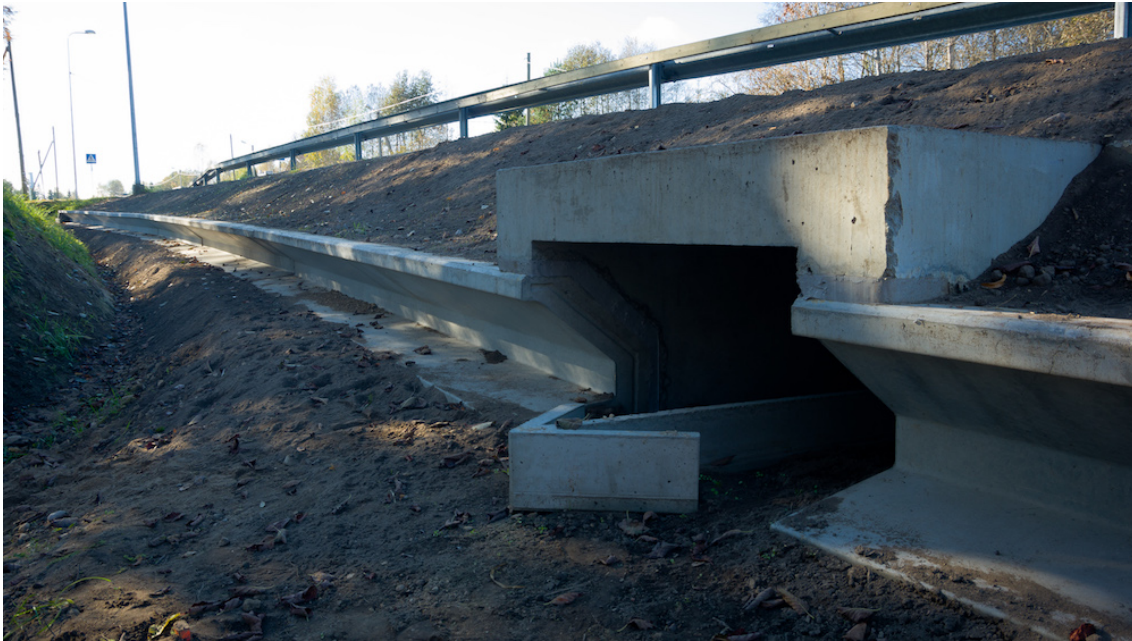
Foto 4. Suunav ja varjav kahepaiksetõke ja kandilise ristlõikega läbipääsulahendus Kiisal. Kasutatud on betooni, mis on kahepaiksete läbipääsulahenduste puhul hea ehitusmaterjal. Fotol kujutatud ala on taimestumata sest foto jäädvustati vahetult pärast ehitust.
